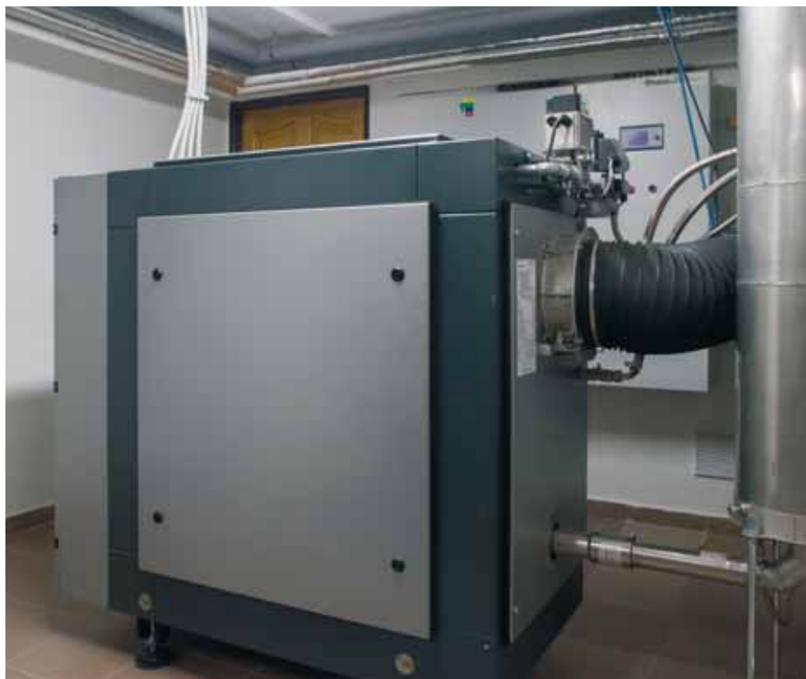
Kogeneračná jednotka Viessmann Vitobloc 200 je prvou kogeneračnou jednotkou inštalovanou v rodinnom dome na Slovensku.
