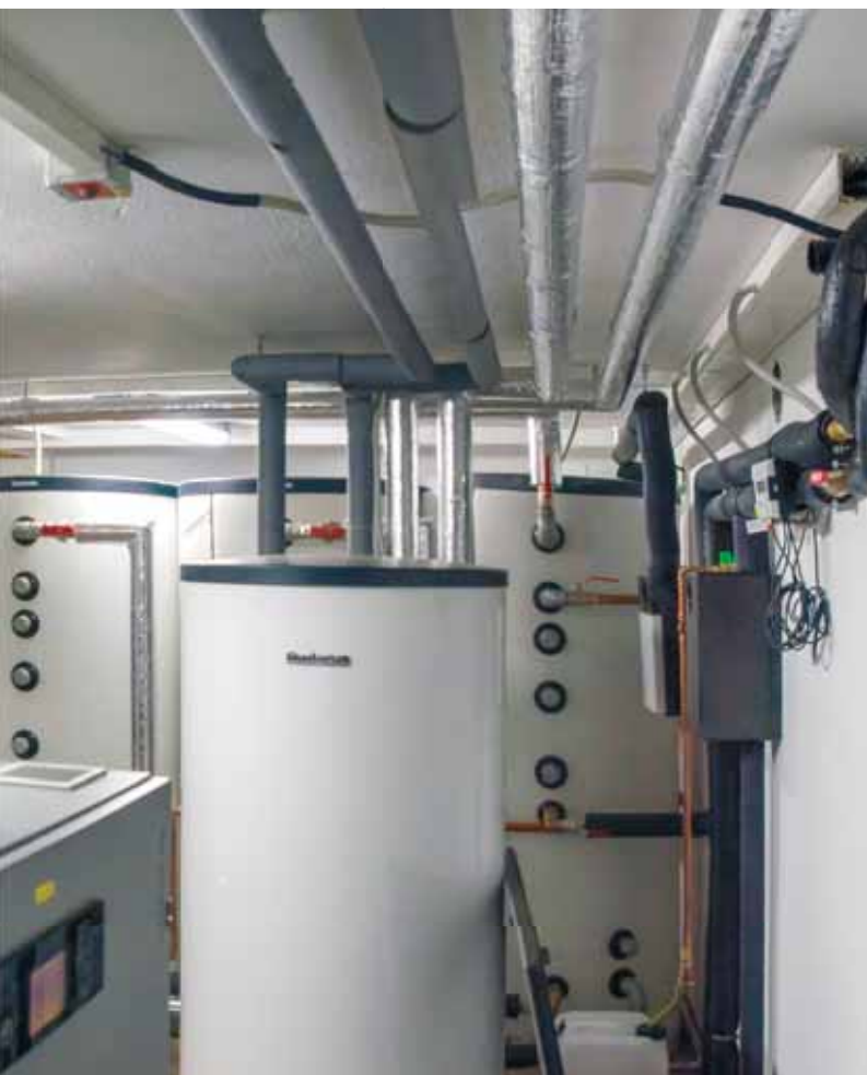
Technologická miestnosť je umiestnená v pivničných priestoroch domu. Celkom vľavo sa nachádza rozvodná skriňa riadiaceho systému Elesta, v popredí kogeneračná jednotka, za ňou pri dverách kondenzačný plynový kotol, vpravo akumuláčnej nádrže na TUV (1 x 300 litrov), na podporu vykurovania (3 x 500 litrov). Za nimi je umiestnená sústava akumulátorov a vnútorná jednotka TČ.
